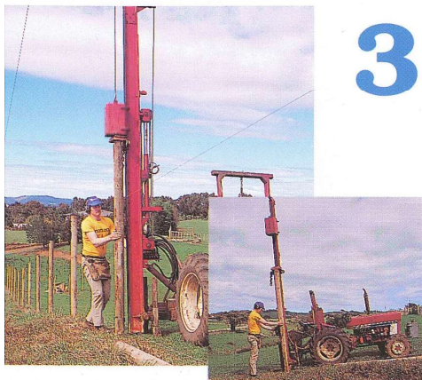
Mise en place des pieux
