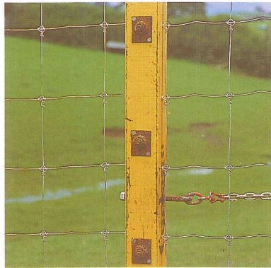
Ondulations correctement tendues sur la gauche
