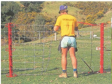
Raccord des nappes de grillages (hors tension entre les barres)
