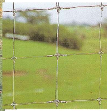
Les nœuds se chevauchent deux par deux, puis les fils horizontaux sont ligaturés
